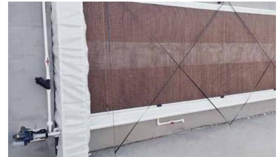
Система зашторивания (скручивание на трубу внизу)
