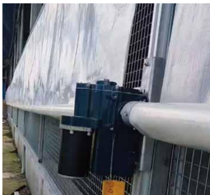
Система зашторивания
