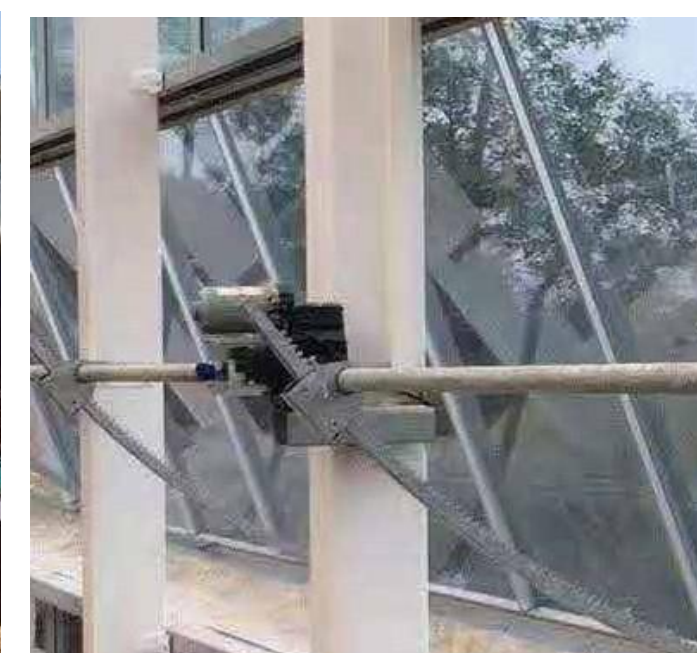
Система речной вентиляции
