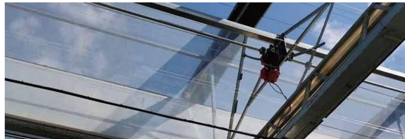
Система реечной вентиляции крыши
