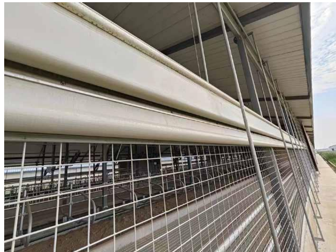
Система зашторивания (скручивание сверху-вниз)
