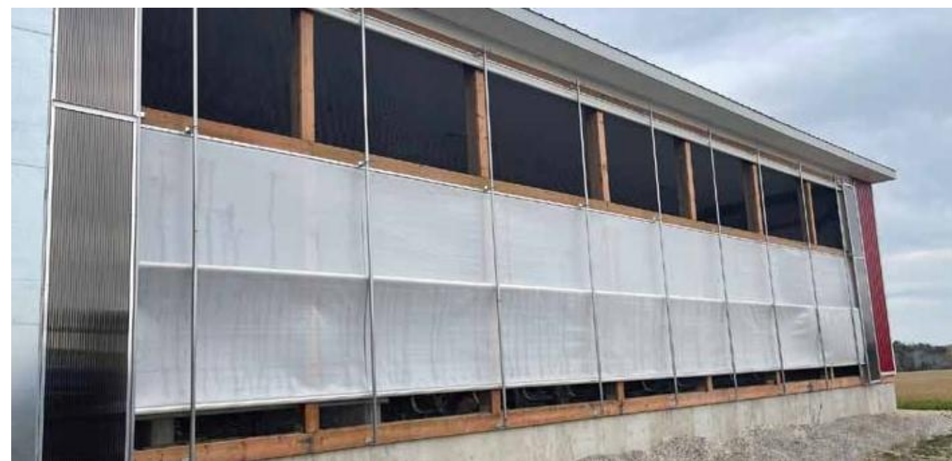
Система зашторивания
