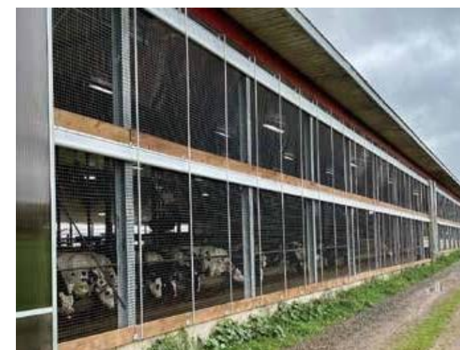
Система зашторивания (снизу-вверх)
