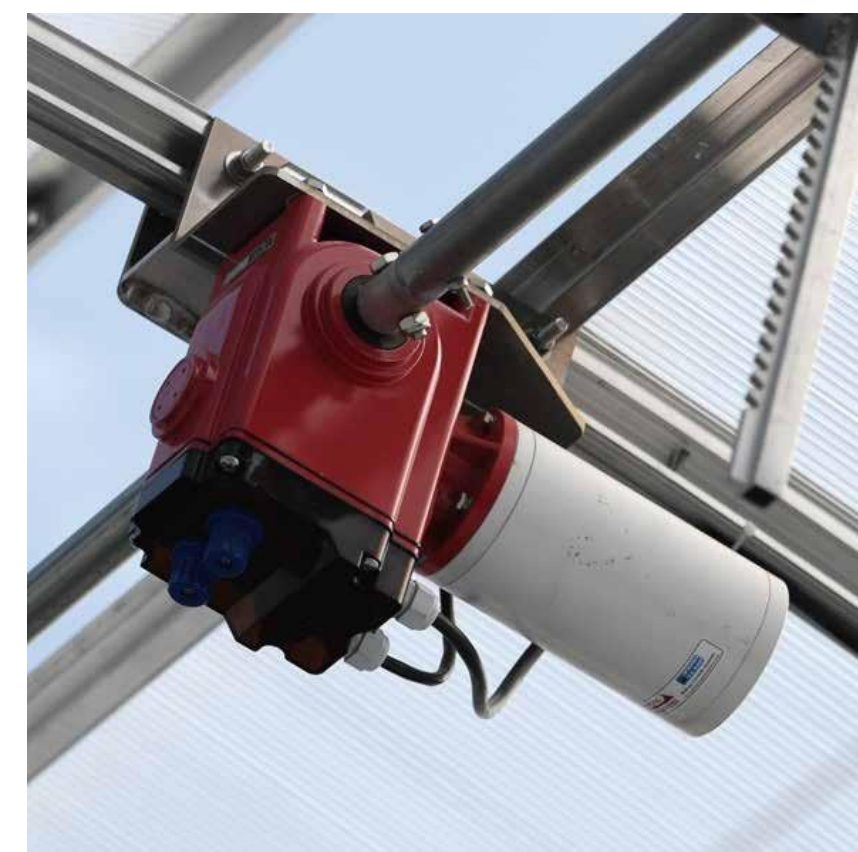
Система речной вентиляции крыши
