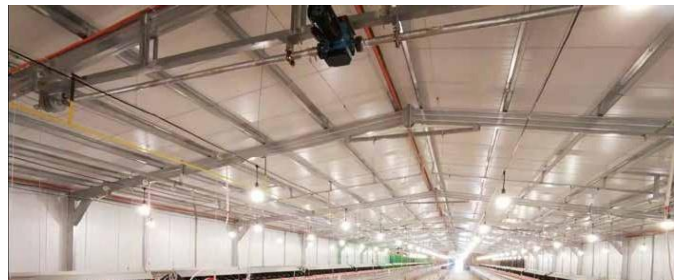
Подъемная система подачи корма
